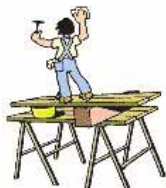
Fig. 4. Altura de la plataforma de trabajo conseguida de forma insegura
